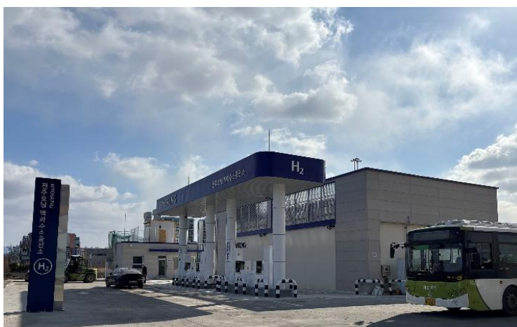
Figura 19.- Estación de repostaje de hidrógeno para autobuses de pila de combustible en Corea del Sur. Fuente: Linde.
