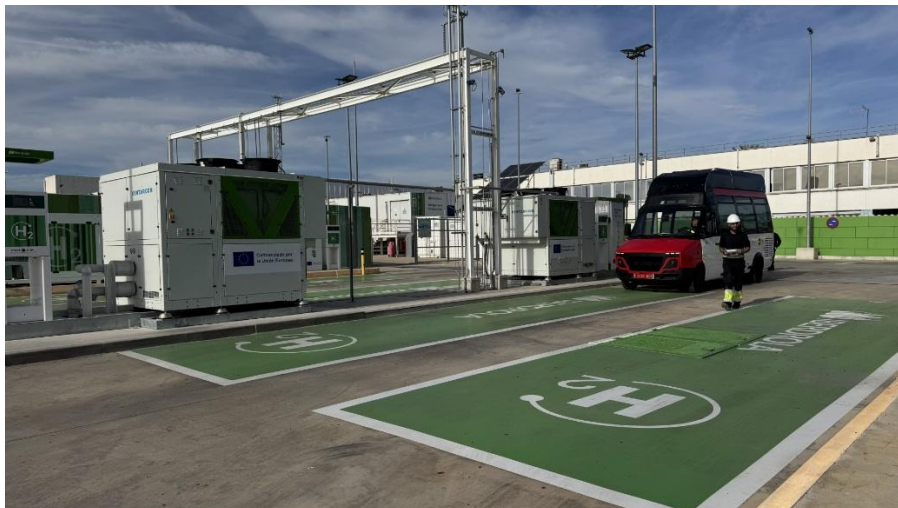
Figura 14.- Estación de repostaje de hidrógeno en la Zona Franca de Barcelona. Fuente: J.R. Morante
