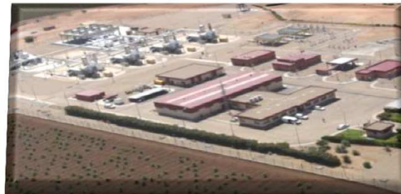
Estación de Compresión de Almendralejo
