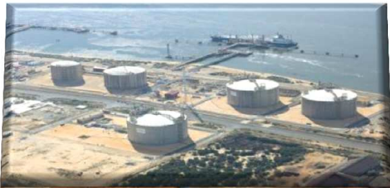
Planta de Regasificación Huelva
