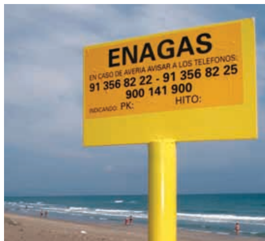
Señalización del trazado del gasoducto
