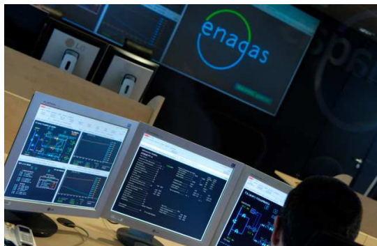
Centro Principal de Control de Enagás
