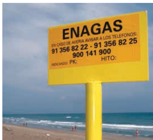
Señalización del trazado del gasoducto
